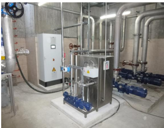
Bild 3: 3 kW Anlage Klärwerk Bad Lippspringe (2019)
